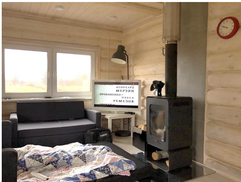
Рис. 7, 8. Металлич. печь и ТермоФан на ней для ускорения конвектив. прогрева
