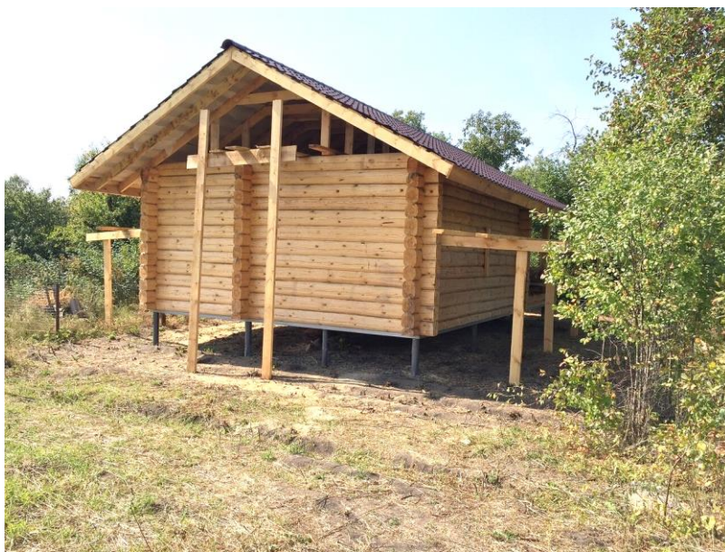
Рис. 3. Баня на сваях. Большой козырёк кровли.
