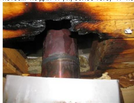
*Рис. 1.2.Б. Возгорание потолка в бане с металлич. печью.*
