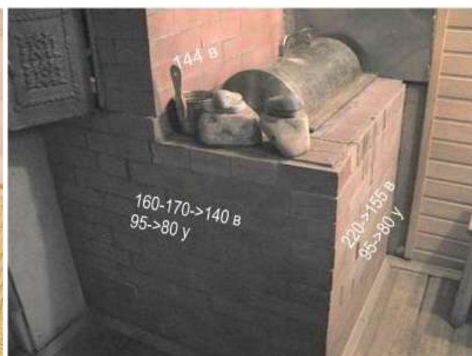
Рис. 5 – Л – у Молоканова и R – у Петрушова. Температура в месте контакта дым.трубы с деревянной балкой возможно была 170-220^\circ\text{C} - так было при тесте минипечи Молоканова и Петрушова:
