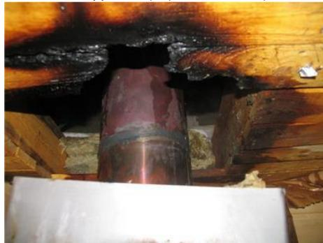
*Рис. 1.2.Б. Возгорание потолка в бане с металлич. печью.*
