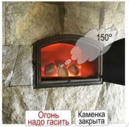
Рис. Э-2. Накал-печь по-серому, т.к. заряд каляется в огне (по-чёрному), но сама печь с трубой, т.е. по-белому. Каменка закрытая с дверкой.
