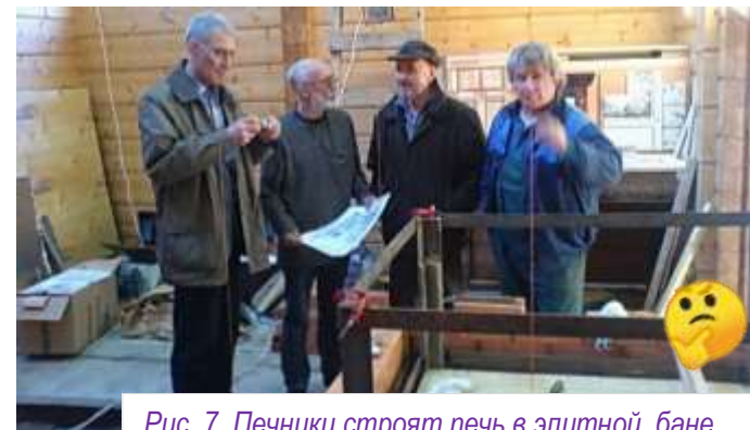
Рис. 7. Печники строят печь в элитной бане.
