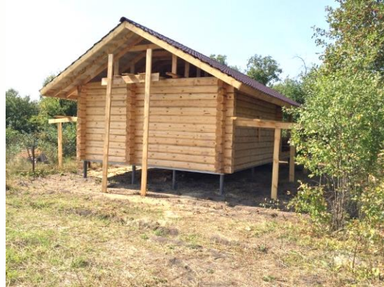
Ф.4. Строим баню. Баня на сваях. Большой козырёк кровли. ...
