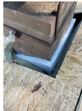
Рис.12 Дымтруба и УПП до и после пожара - Иркутск от Ерёмкина С. По присланным материалам Можно понять, что поддержание огня в печи в ожидании клиента, и потом сильная протопка при работе с клиентом – всё это привело к возгоранию.
