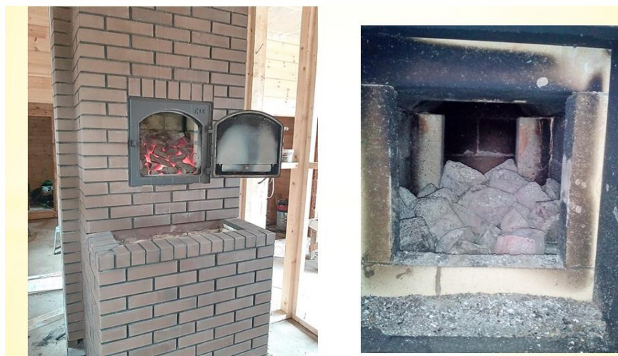
Рис.9 Накал-каменка, калим камни, чугун и поливаем водой. Экология = 0. Пепел, зола – печь по серому - каменка по-чёрному.
