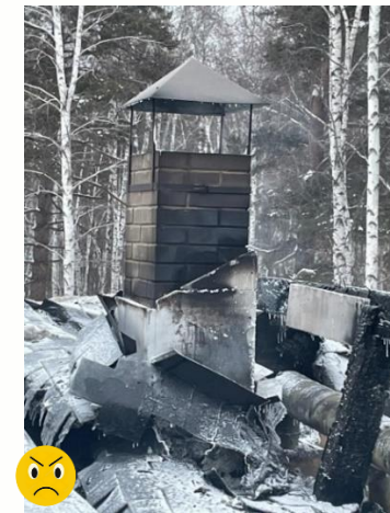
Рис.12 Дымтруба и УПП до и после пожара - Иркутск от Ерёмкина С. По присланным материалам Можно понять, что поддержание огня в печи в ожидании клиента, и потом сильная протопка при работе с клиентом – всё это привело к возгоранию.
