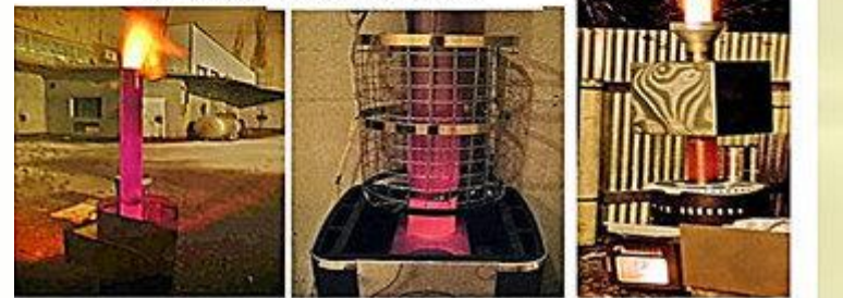
Рис. 4. Огонь из трубы над крышей и раскалённые ДТ, риск пожара высок!
