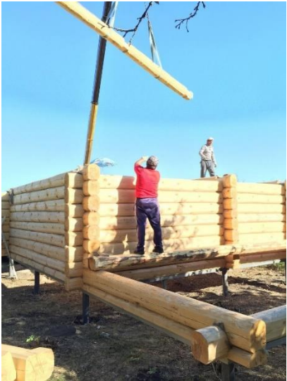
Ф.4. Строим баню. Баня на сваях. Большой козырёк кровли. ...
