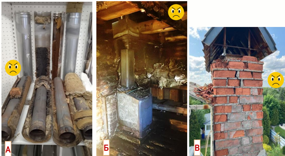
Рис. 6. ♦ Слева - А перекалённые дымтрубы после МП – Зона 3 на рис. 2. ♦ Возгорание в парной - Б , дер. Кашино, МП RedMis, пожарных не вызывали, огонь "задохнулся" при закрытых дверях без притока воздуха. ♦ Справа - В – кислотный конденсат разрушил витебский кирпич после водогрейного газ. котла.
