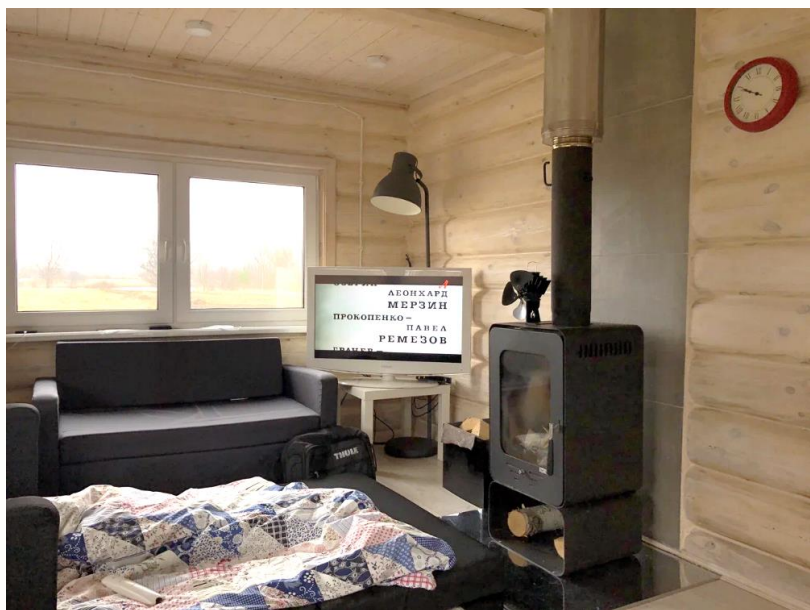
Ф.8. Металлич. печь и ТермоФан на ней для ускорения конвектив. прогрева
