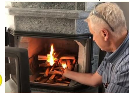
Рис. 15 Поджиг и горение сверху увеличивает КПД сгорания и отбора тепла. Пономарёв А.В. разжигает сверху Для 2-й закладки сдвигает угли к задней стенке. Там и начинается "боковое" горение.
