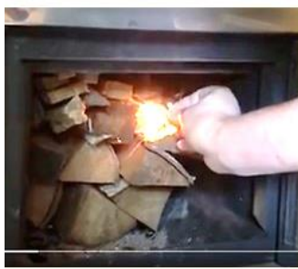
Рис. 7-1,а Поджиг и горение сверху увеличивает КПД сгорания и отбора тепла. Пономарёв А.В. разжигает сверху. Для 2-й закладки сдвигает угли к задней стенке. .
