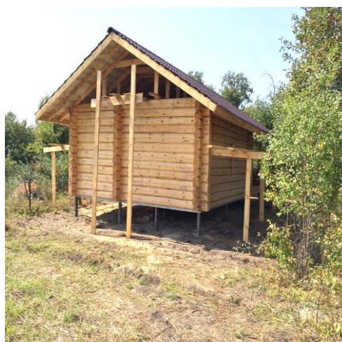
Рис.9-6. Строим баню на сваях. Большой козырёк кровли.
